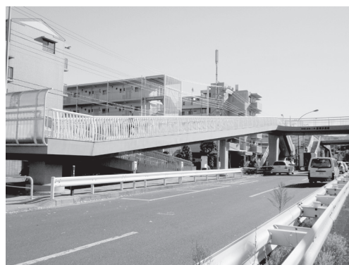
【写真10.1】 スロープの設置例
